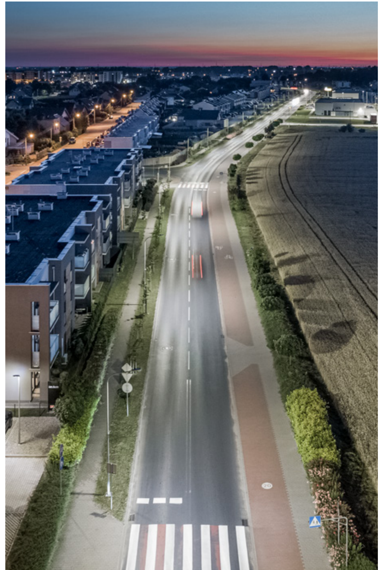
Oświetlenie drogowe w Środzie Wielkopolskiej
