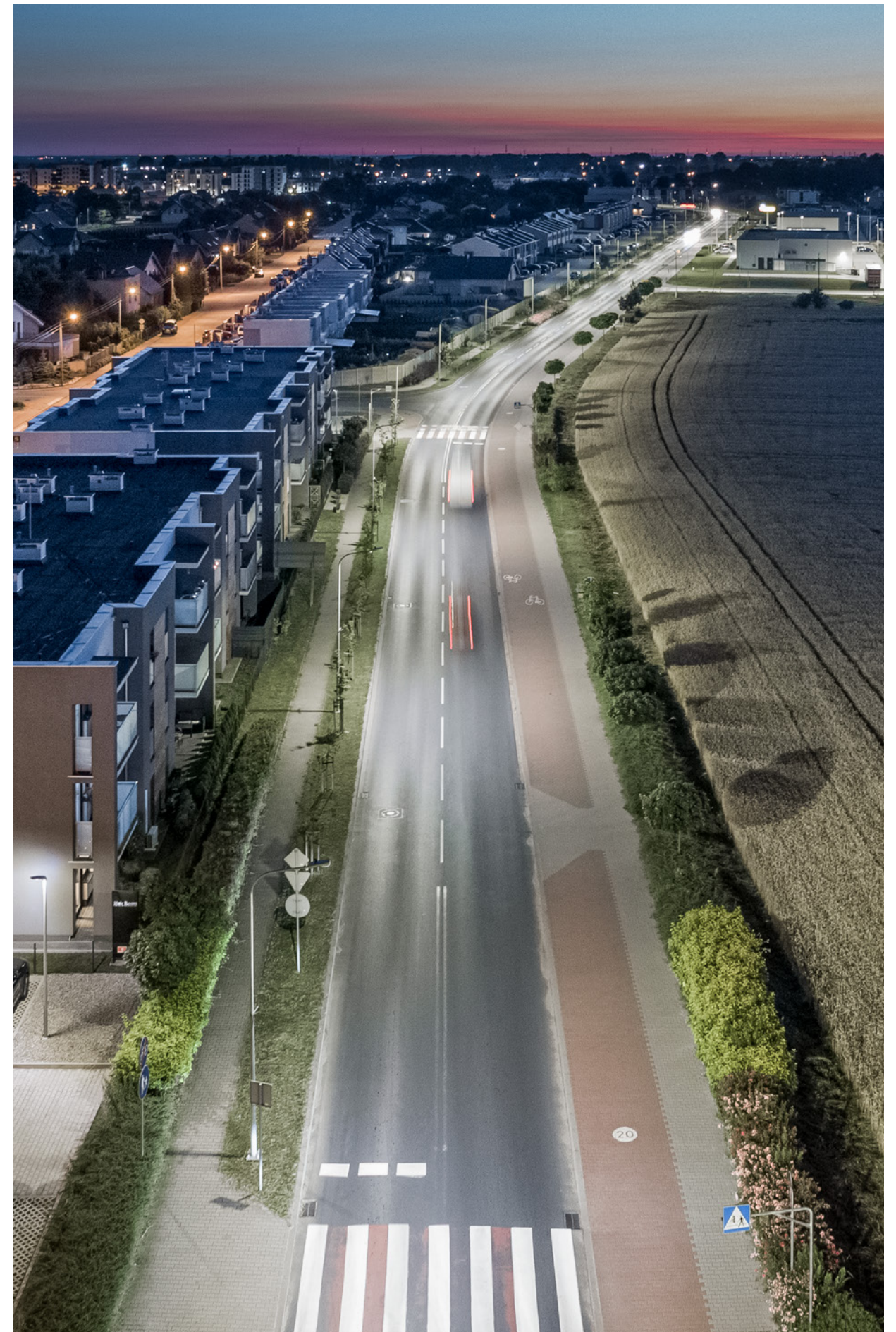
Oświetlenie drogowe w Środzie Wielkopolskiej
