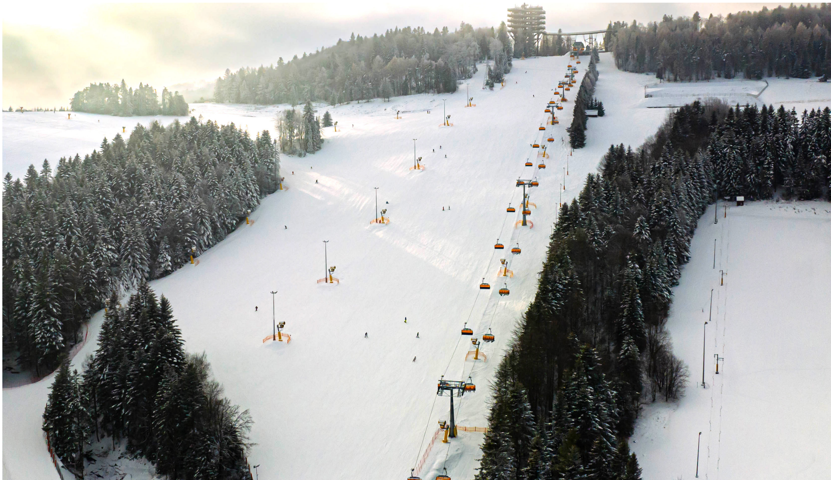
Oświetlenie stoku narciarskiego Stotwiny Arena
