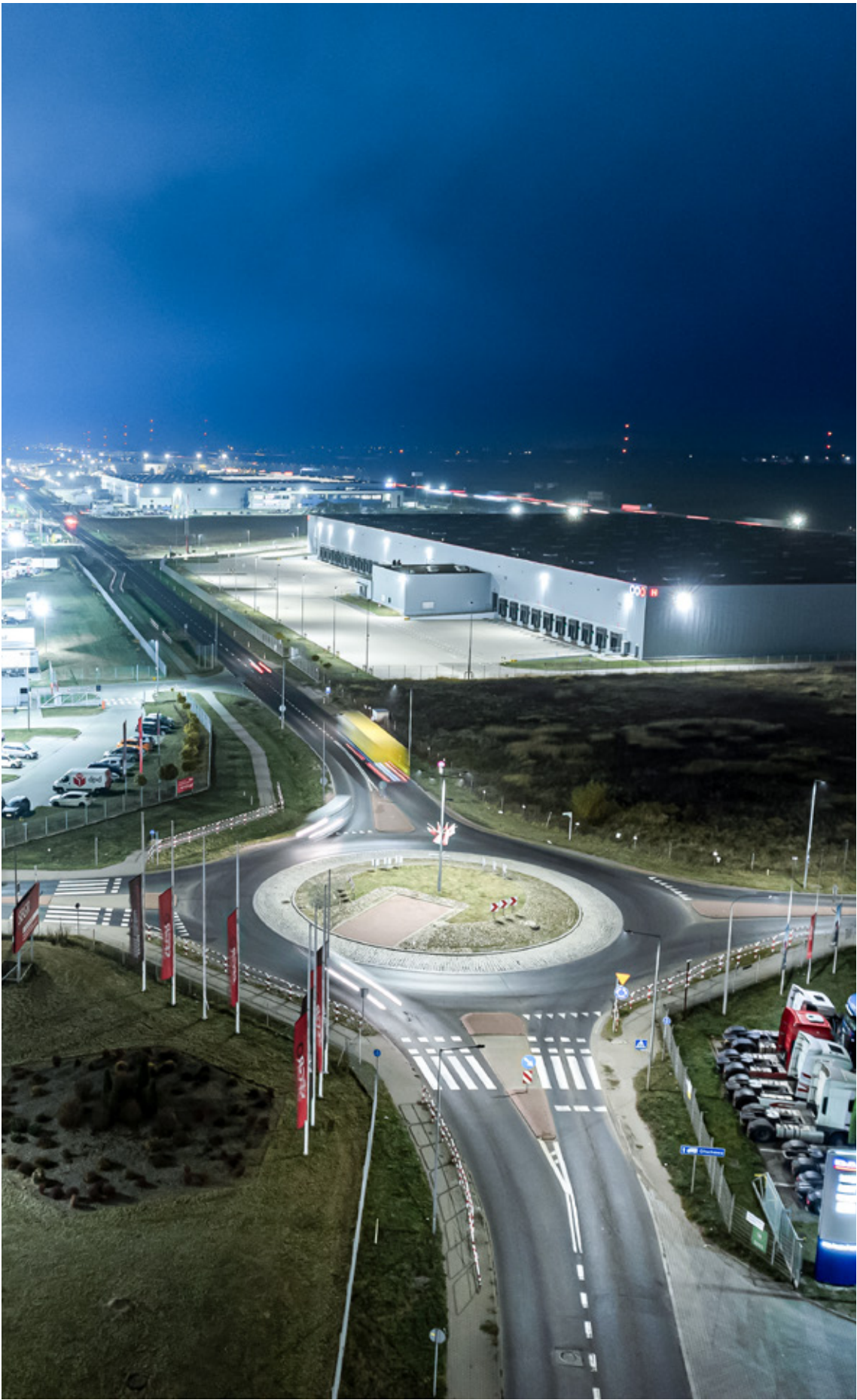
Zastosowanie opraw Astra LED Alu
