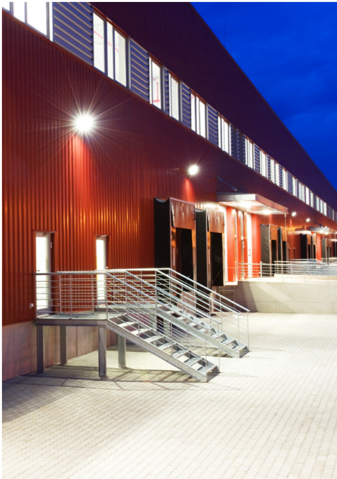
Zastosowanie lamp Quest 2 LED do oświetlenia ramp rozładunkowych.
