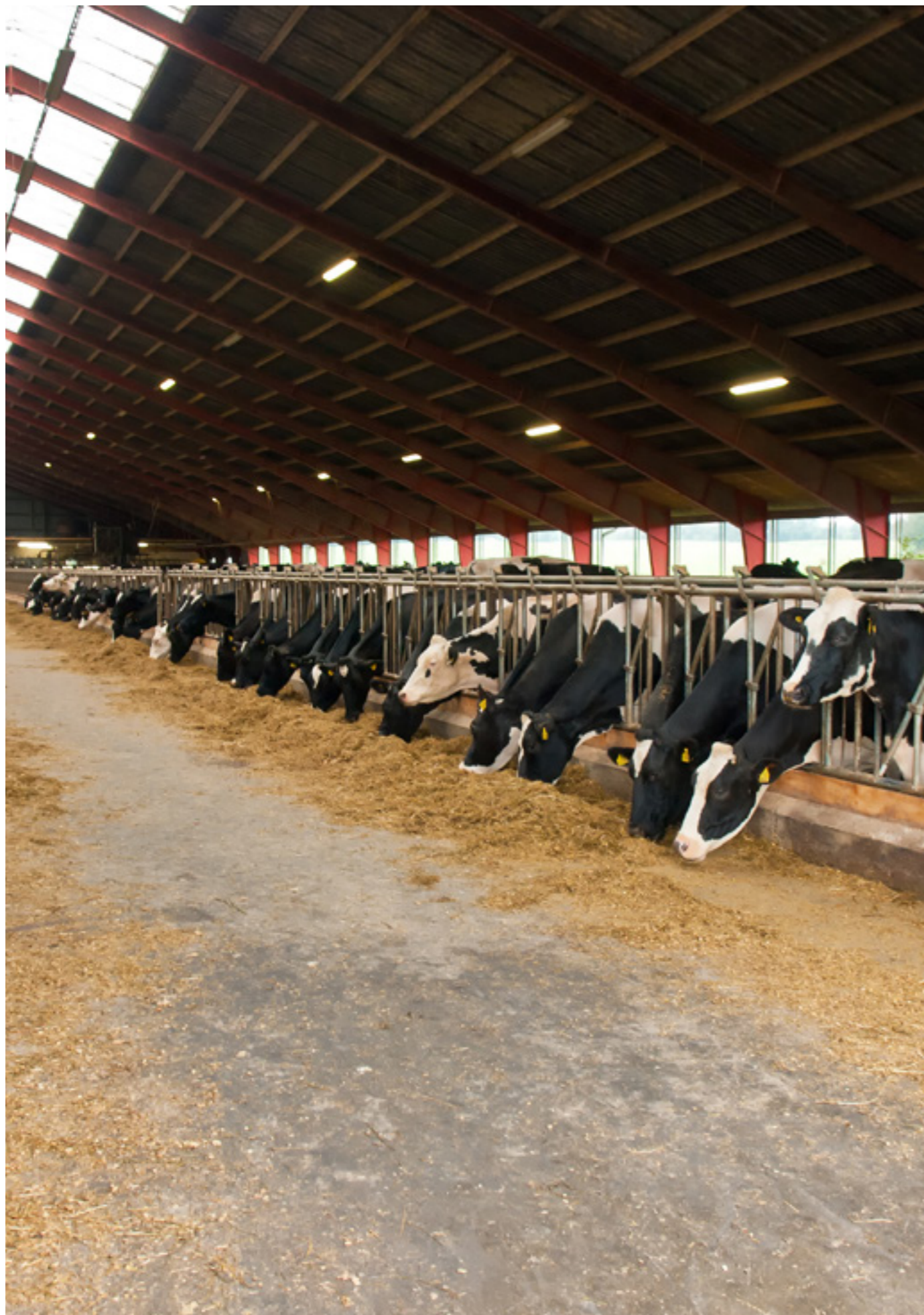
Zastosowanie lamp Tytan 2 LED Chemo w hali produkcyjnej
