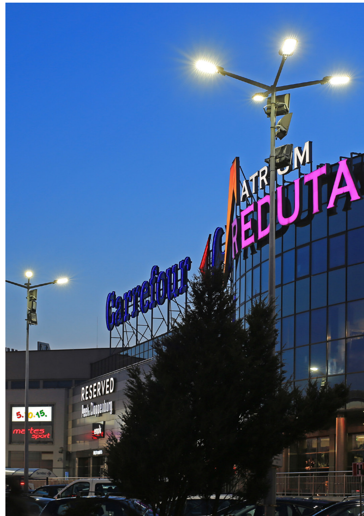
Zastosowanie lampy Astra LED na parkingu przed Centrum Handlowym Reduta w Warszawie
