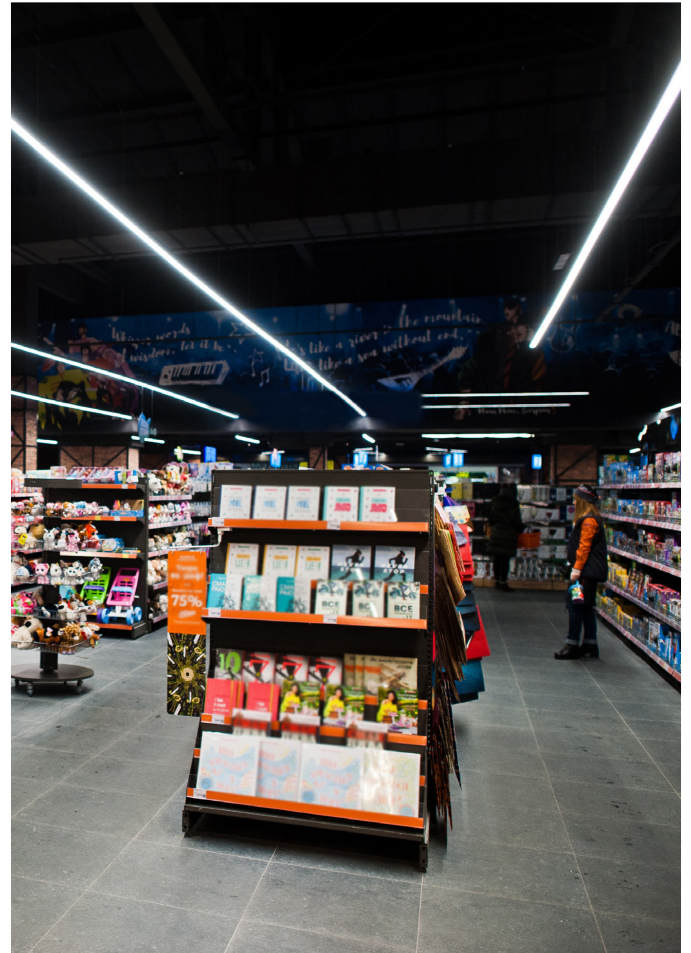
Zastosowanie linea Linea 3 LED w sklepie wielkopowierzchniowym.
