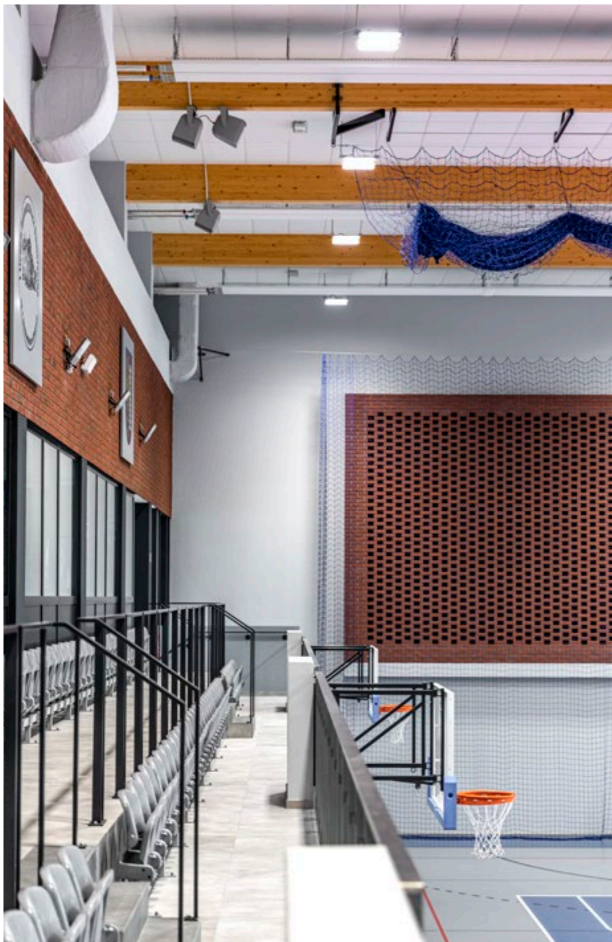
Oświetlenie boiska sportowego w Gliwicach
