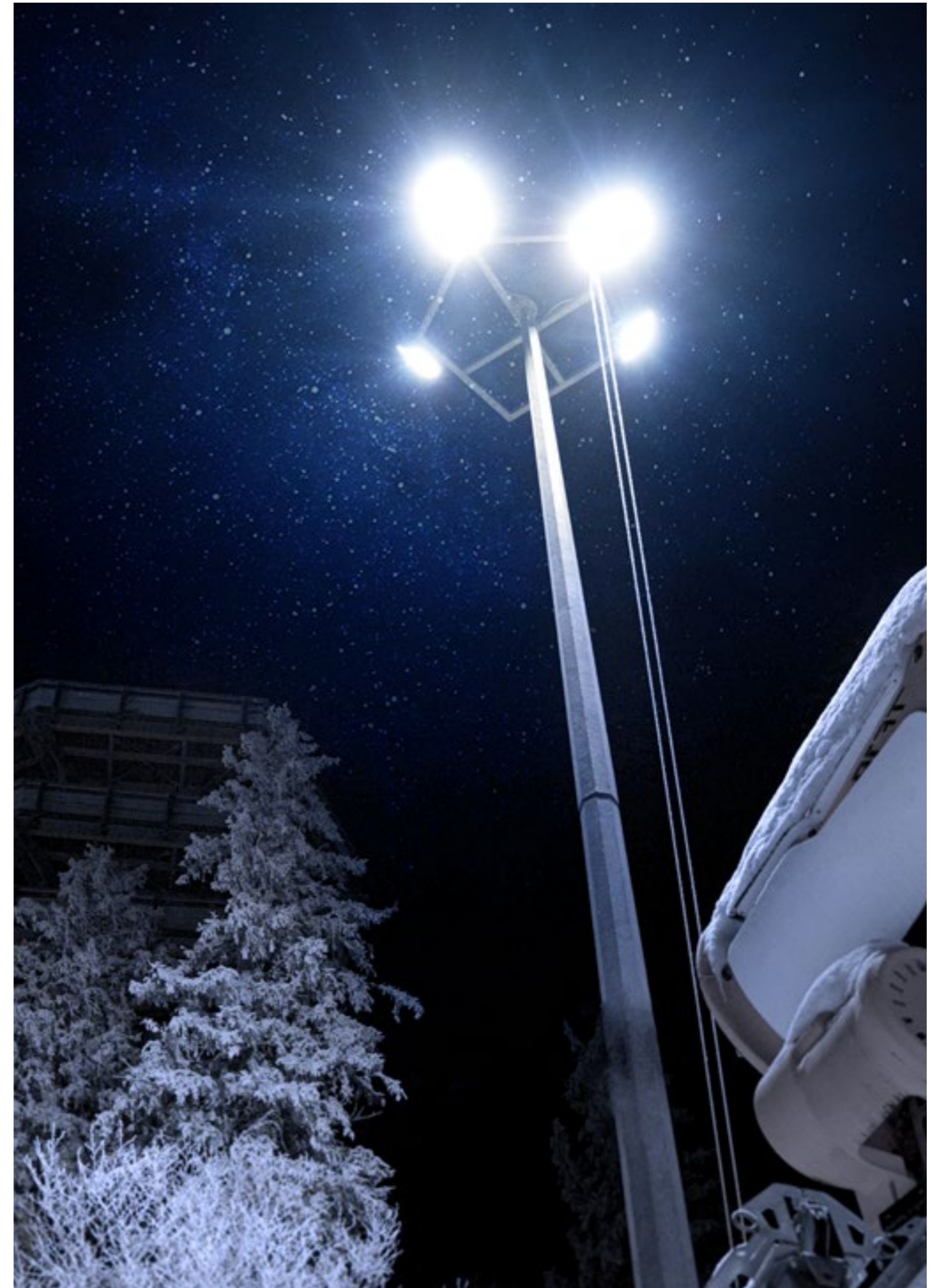
Oświetlenie stoku narciarskiego Stotwiny Arena
